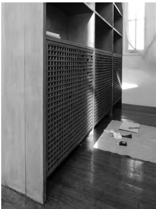
図5 修復中 書棚下の格子枠 破損箇所を膠水で仮止め処置
