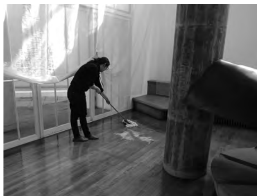
図4 修復中 床 補彩後に水性樹脂ワックスを4度塗布
