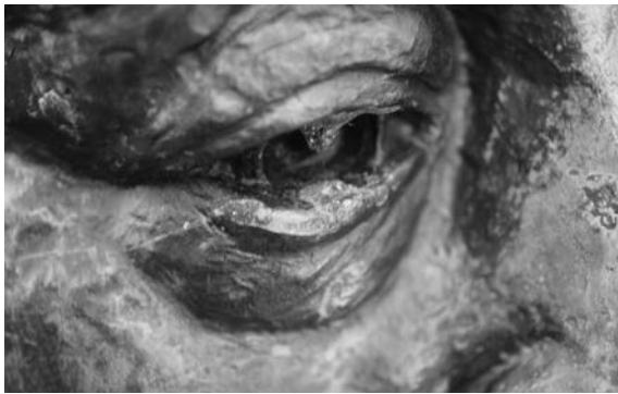
樹脂による補修箇所
